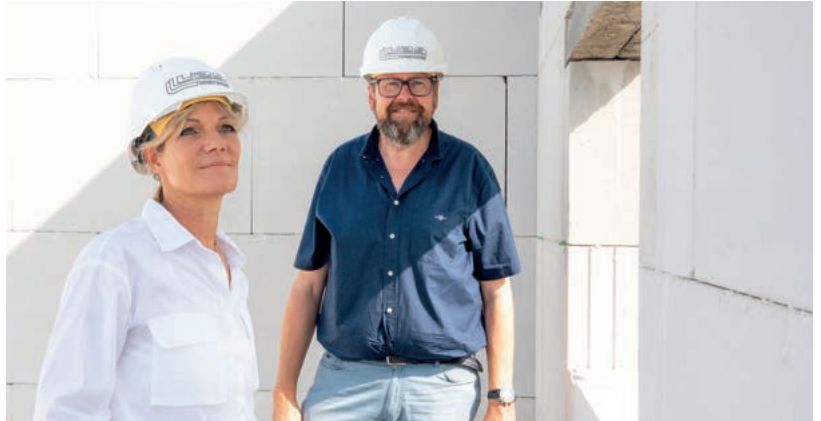
Assistentin Weiler und Vorstand Weiner auf der Baustelle. Baubeginn war im Mai 2025. Der Einzug soll spätestens im September 2026 stattfinden.
