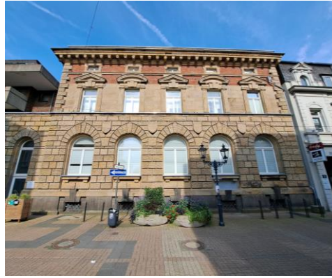
Sanierung Baudenkmal Niederstraße 26 in Uerdingen (Quelle: IRI)
