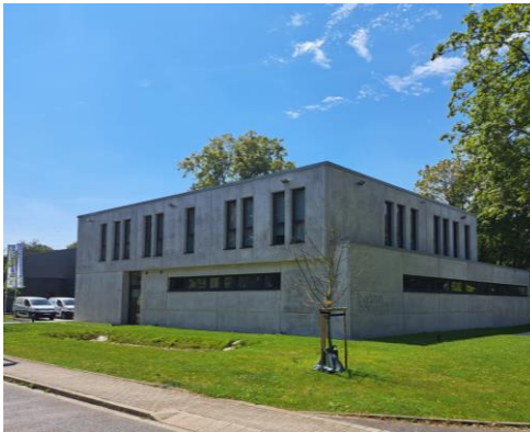
Neues Verwaltungsgebäude mit Prüflabor der beton consult GmbH an der Fichtenhainer Allee (Quelle: IRI)
